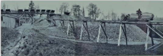
Les mines de charbon de Saint-Martin - Le Jordil
